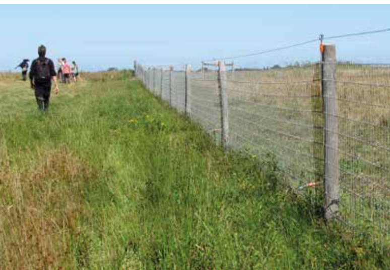
— Ein massiver Knotenflechtzaun mit Elektrolitze verhindert das Eindringen von Raubsäugern in die Salzwiesenbereiche der Halbinsel Bresewitz. Foto: Christof Herrmann
