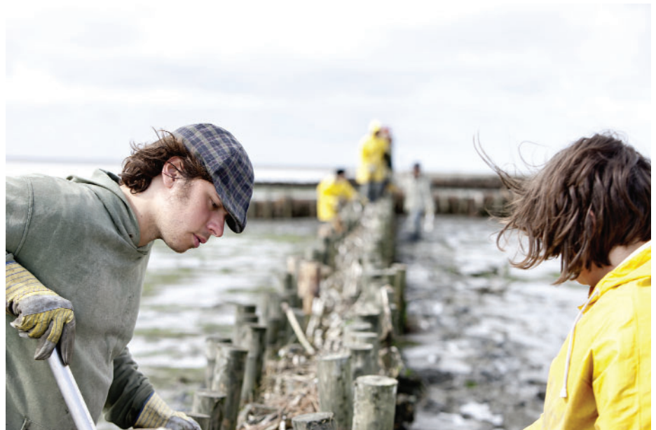
Wichtigste Arbeit im Küstenschutz auf Norderoog ist der Lahnungsbau.
