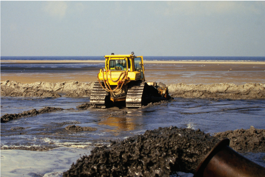
Geburt einer Insel: Sand wird aufgespült und zusammengeschoben.
