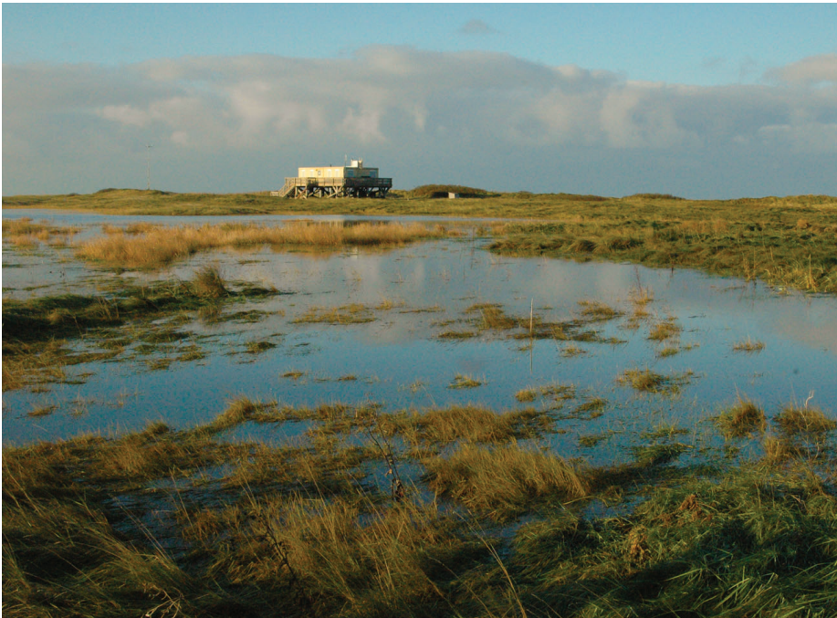
Die aktuelle Vogelwärterhütte – zum Schutz vor Sturmfluten auf Pfählen errichtet – ist nicht mehr bewohnbar und muss dringend ersetzt werden. Foto: Archiv Verein Jordsand
