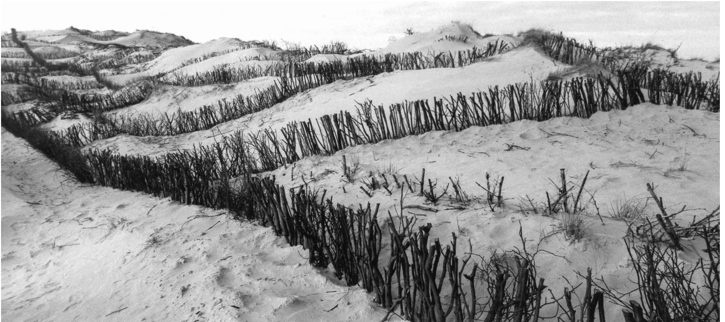
Nach Sturmflut- und Windeinbrüchen am westlichen Dünenwall werden durch Sandfangzäune neue Wälle aufgebaut.
