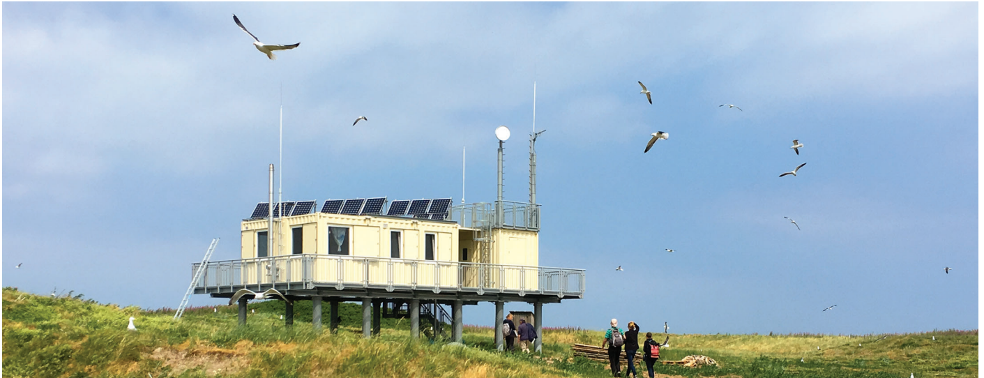
Im letzten Jahr wurde auf Scharhörn eine neue Vogelwärrerhütte errichtet.
