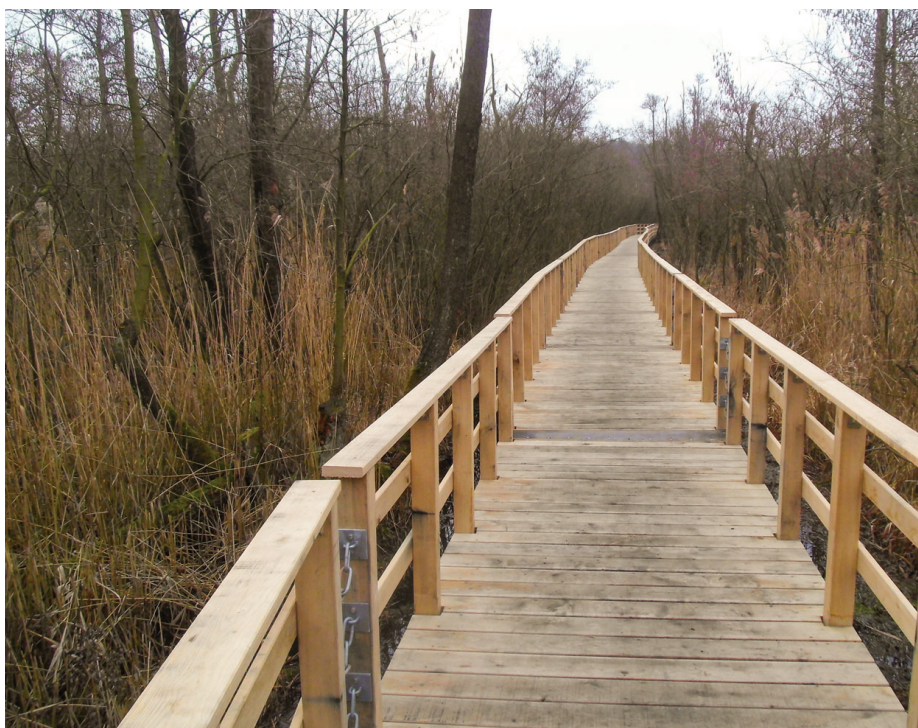
Alle Pontons sind am 20.02.2019 eingebracht und fertig montiert.
