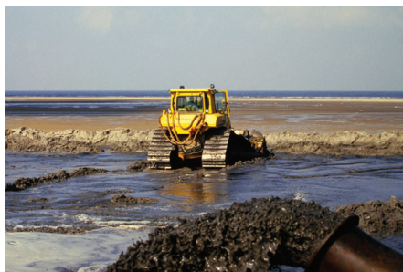
Geburt einer Insel: Sand wird aufgespült und zusammengeschoben. Foto: Archiv Verein Jordsand
