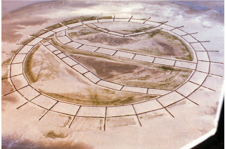
Sandfangzäune bilden das „Gerippe“ der neuen Insel Nigehörn.
